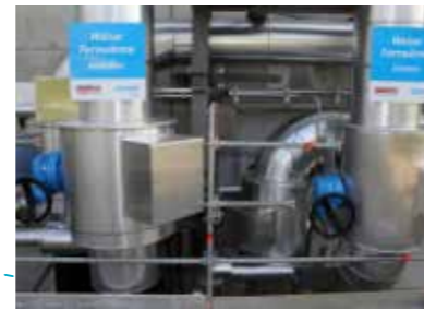
2022 Fernwärme Erweiterung Nord
